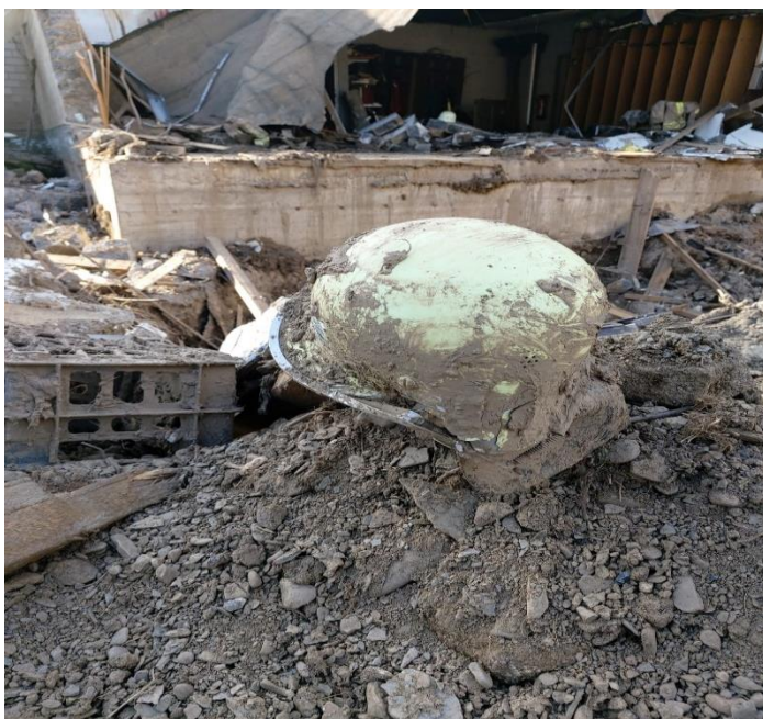
Auch das Gerätehaus der Feuerwehr Rech wurde komplett zerstört
